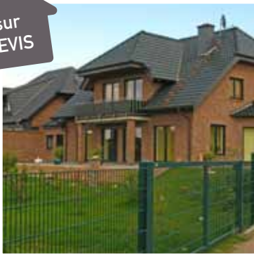
Pose de clôture
