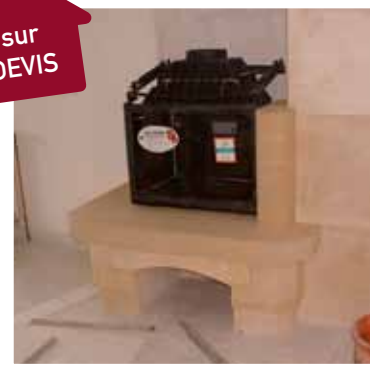
Pose de cheminée
