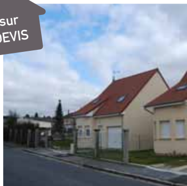
Enduit sur façade
