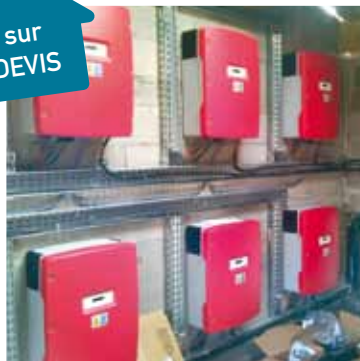
Installation réseau électrique
